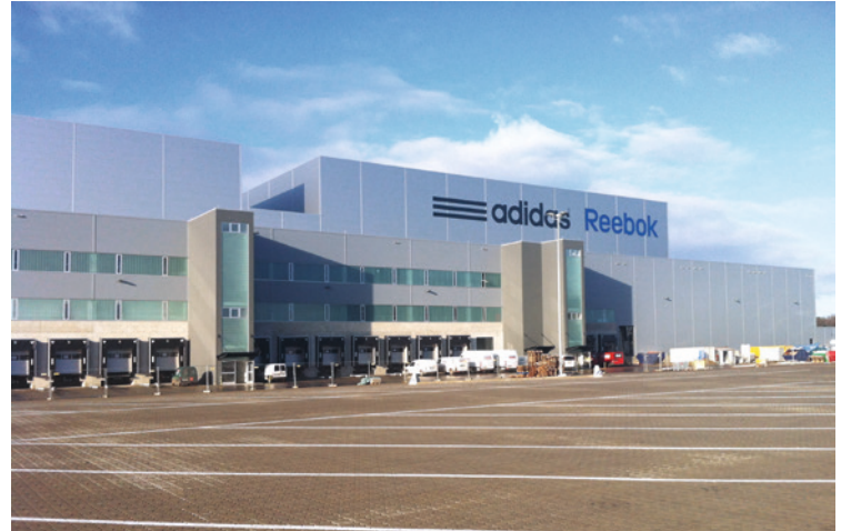
Wärme, Lüftung, Kälte – für das Adidas-Logistikzentrum in Rieste hat airpool eine maßgeschneiderte Komplettlösung entwickelt und installiert
