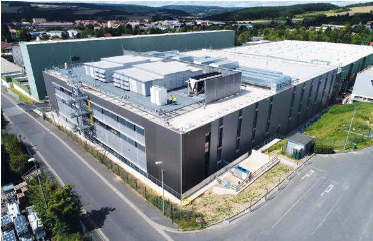
Für das Oral-B-Werk von Procter & Gamble am Standort in Marktheidenfeld hat der Betrieb Be- und Entlüftungsanlagen, inklusive Reinraumtechnik, installiert
